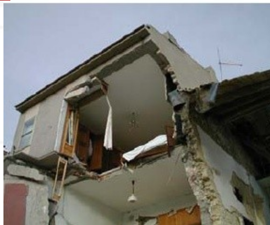
b) nepoželjni mehanizmi urušavanja – izbijanje uglova zgrade
