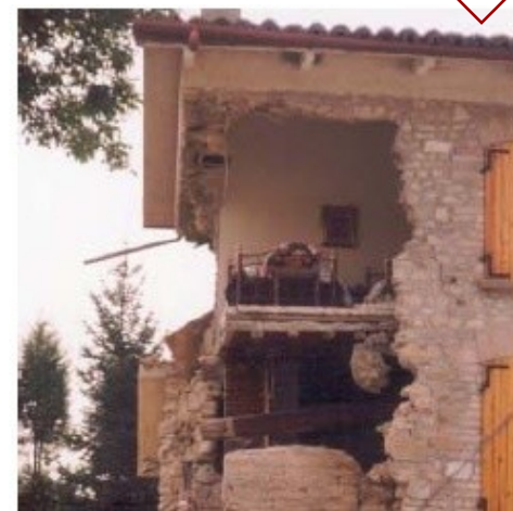
b) nepoželjni mehanizmi urušavanja – izbijanje uglova zgrade
