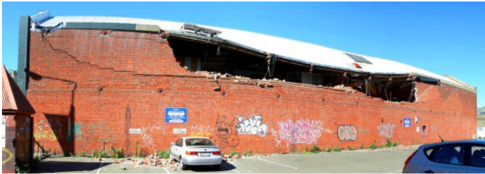
Slom bočno opterećenog zida zbog pomaka “mekane” krovne dijafragme
